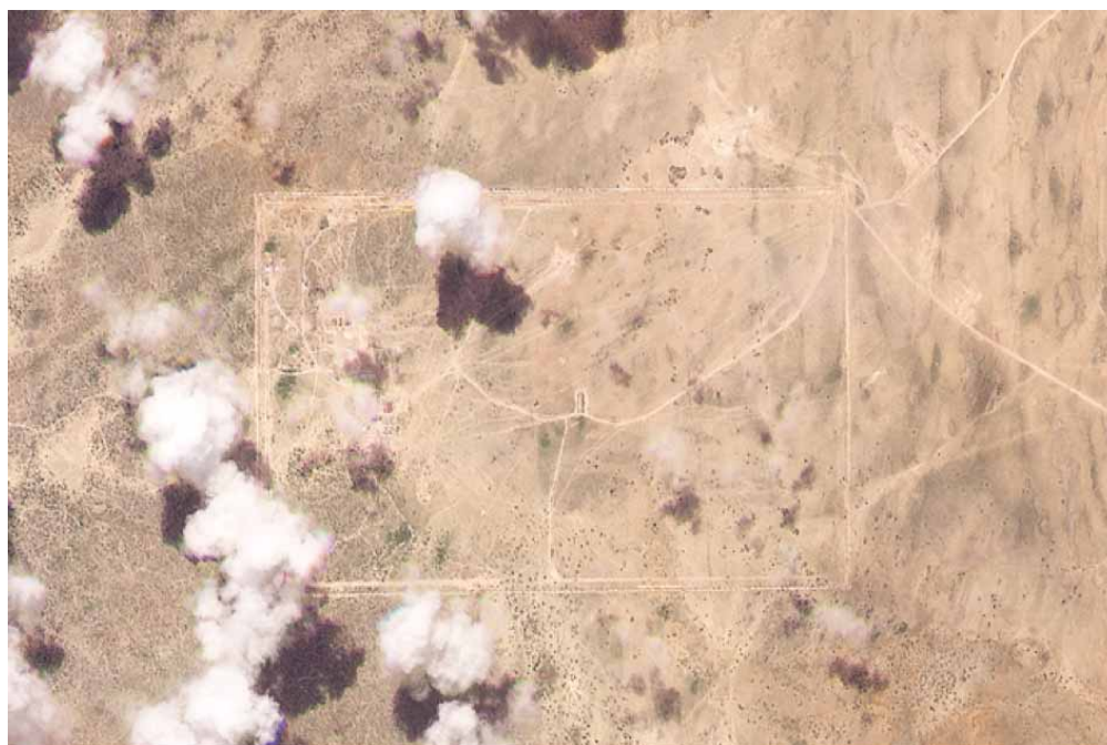
La base spatiale turque en construction à Warsheikh, à 70 kilomètres au nord de Mogadiscio (Somalie), le 23 juin 2026. PLANET LABS PBC
